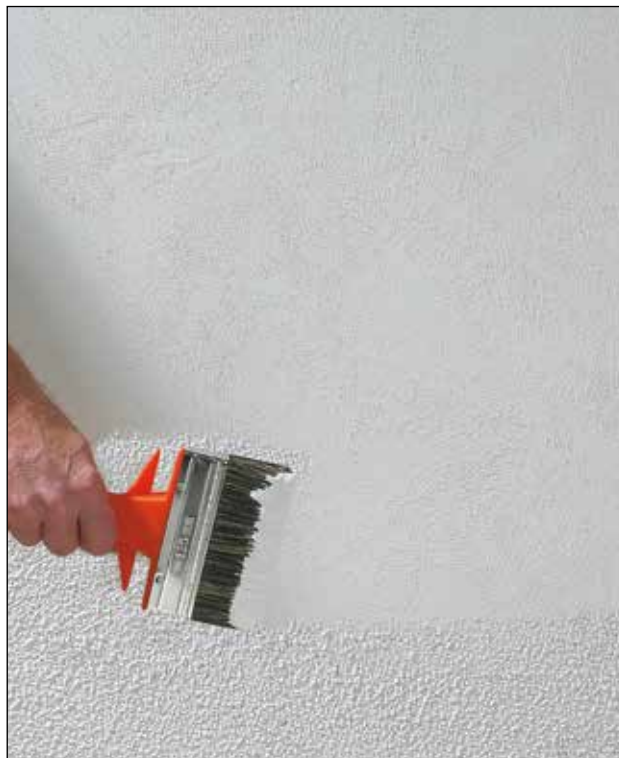
Skalflex Interiør-Struktur FIN påført med pensel.
