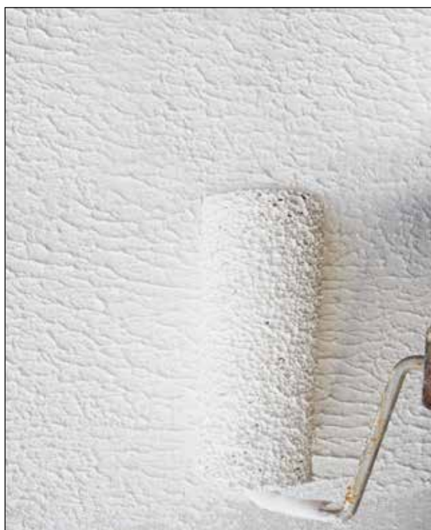
Skalflex Interiør-Struktur GROV påført med strukturrulle.
