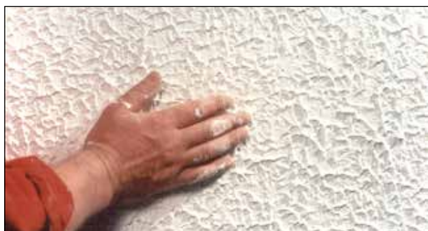
Skalflex Interiør-Struktur bearbejdet med hænderne.
