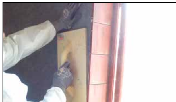
3. Isoleringen trykkes godt fast i limen med et pudsebræt.
