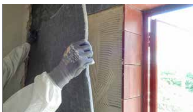
2. Den tilskårne isolering monteres på væggen, og stødes helt sammen med allerede monterede stykker.
