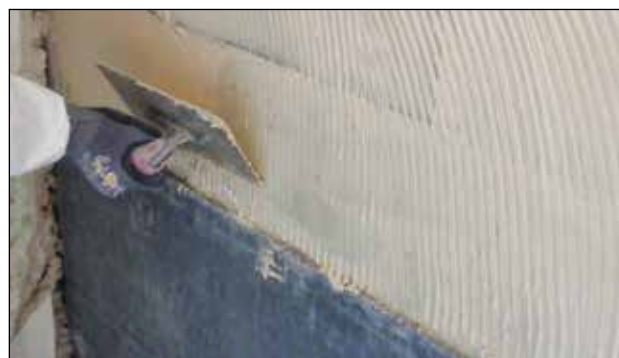
1. Skalflex Pladelim påføres med tandspartel på den klargjorte væg.
