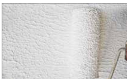
Interiør-GROV påført med strukturrulle.
