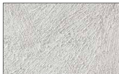
Interiør-SAND bearbejdet med pensel.
