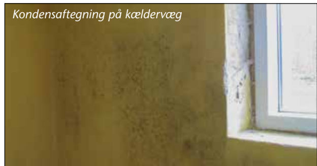
Kondensaftegning under loft
