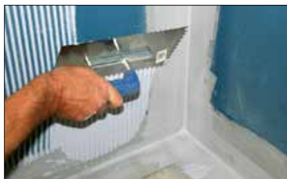
5. For at ensarte lagtykkelsen påføres vådrumsmembranen med tandspartel. Vådrumsmembranen trækkes hen over tætningsbånd og manchetter.
