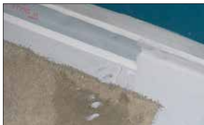
4. De tilpassede tætningsbånd og manchetter placeres i den våde vådrumsmembran. Der skal sikres fuld kontakt mellem bånd/manchet og underlag. Bearbejd med penslen til alle luftlommer er væk.
