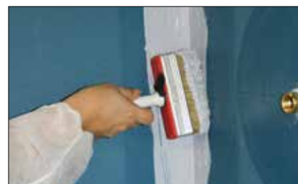
3. Tætningsmembranen påføres i hjørner, langs kanter og omkring afløb og rørgennemføringer.
