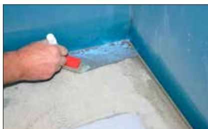
2. Underlaget grundes med Skalflex Vådrumsprimer.
