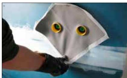
1. Tætningsbånd klargøres i passende længder og manchetter tilpasses rør og afløb.
