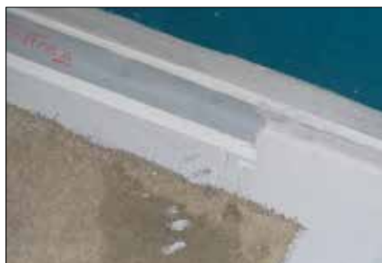
4. De tilpassede tætningsbånd og manchetter placeres i den våde tætningsmasse. Der skal sikres fuld kontakt mellem bånd/manchet og underlag. Bearbejd med penslen til alle luftlommer er væk.
