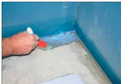
2. Underlaget grundes med den medfølgende Skalflex Primer.
