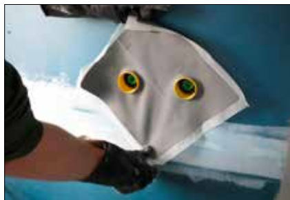
1. Tætningsbånd klargøres i passende længder og manchetter tilpasses rør og afløb.
