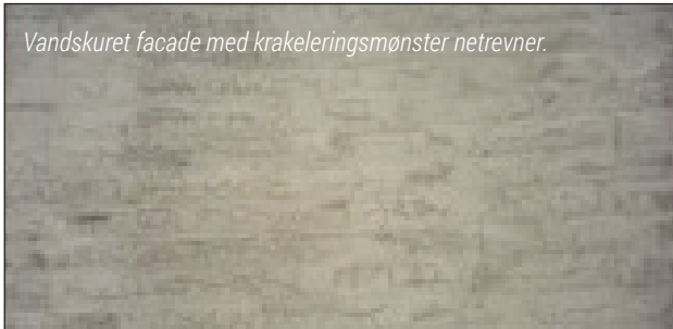
Facade der er malet. Netrevner går igennem malingslaget.
