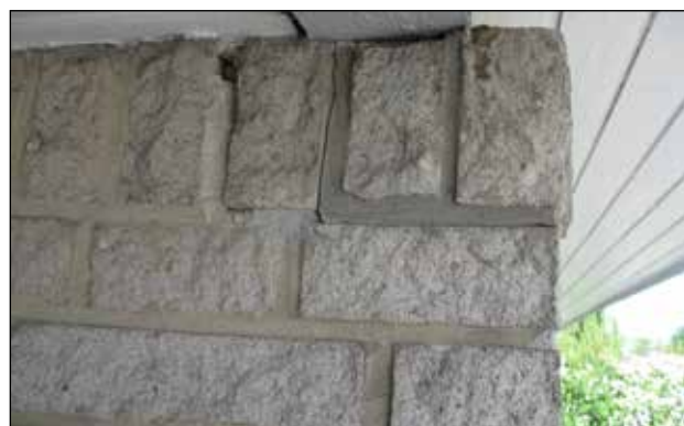
Løst murværk mures om.
